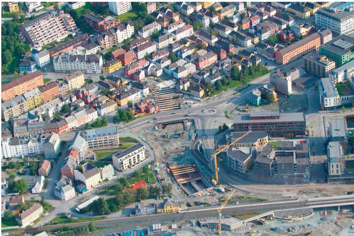
Bilde er fra juli 2013 og viser hvordan trafikken vil sluses bort fra Innherredsveien 7 (øverst til høyre i bildet). Betongtunnel er snart ferdigstøpt på dette bildet.
