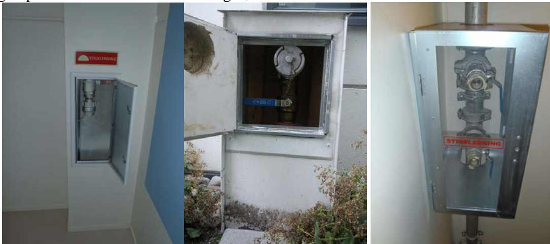
Feil plassering av uttak og påkoblinger.
