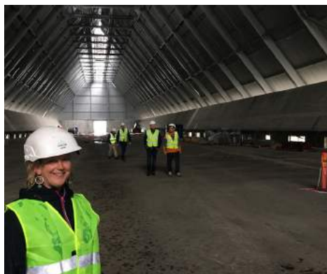
Gunn Brekka i en av flishallene hos Hofor.
